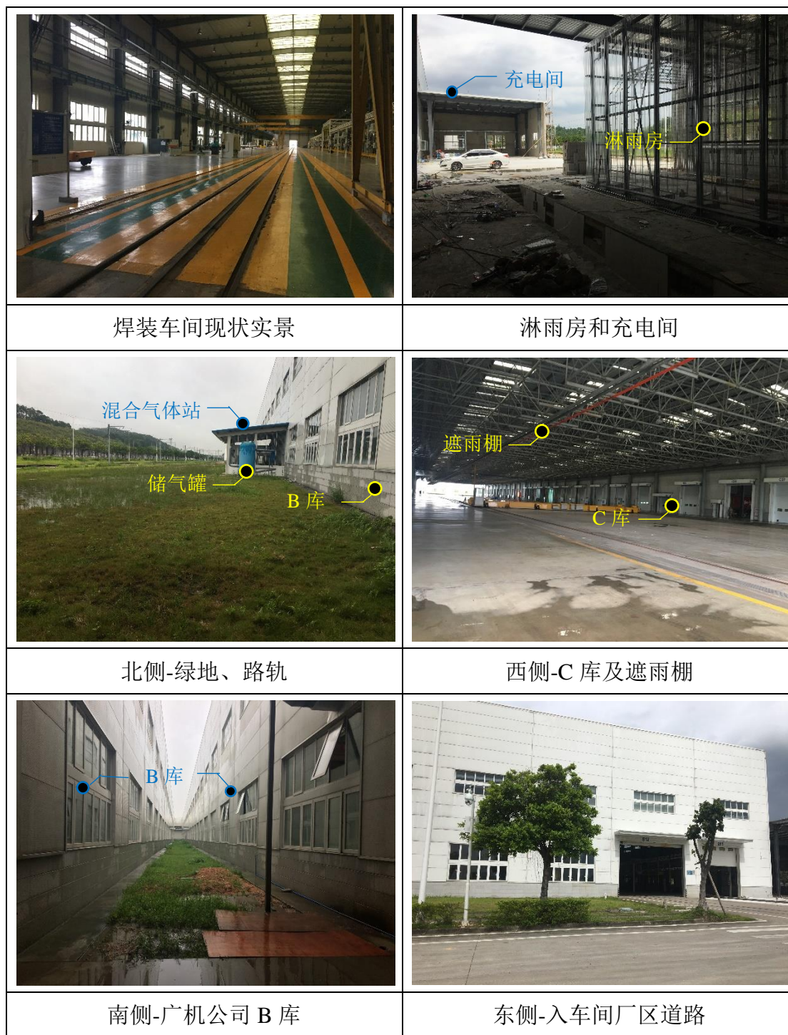
图 3.2-3 本项目焊装车间、总装配套仓库内景及四至实拍照片
