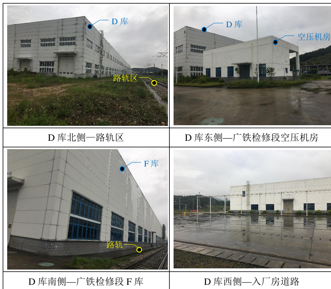
图 3.2-2 本项目总装、调试车间四至实拍照片
