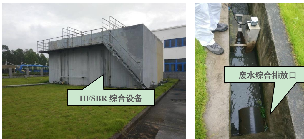
图 6.2-4 生活污水处理设施现场情况
